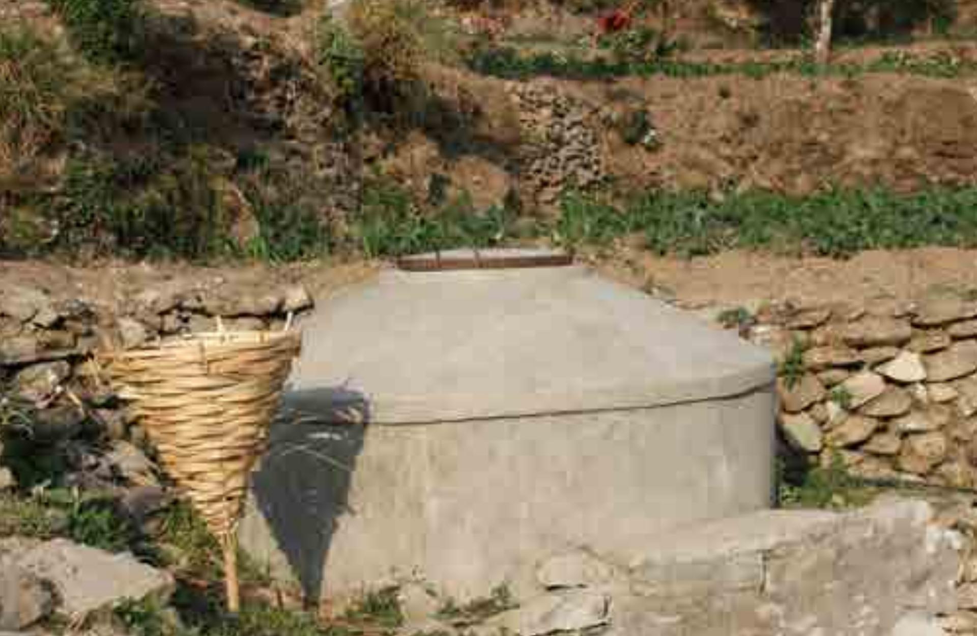
Ein neuer Wassertank - alte Tanks werden renoviert
